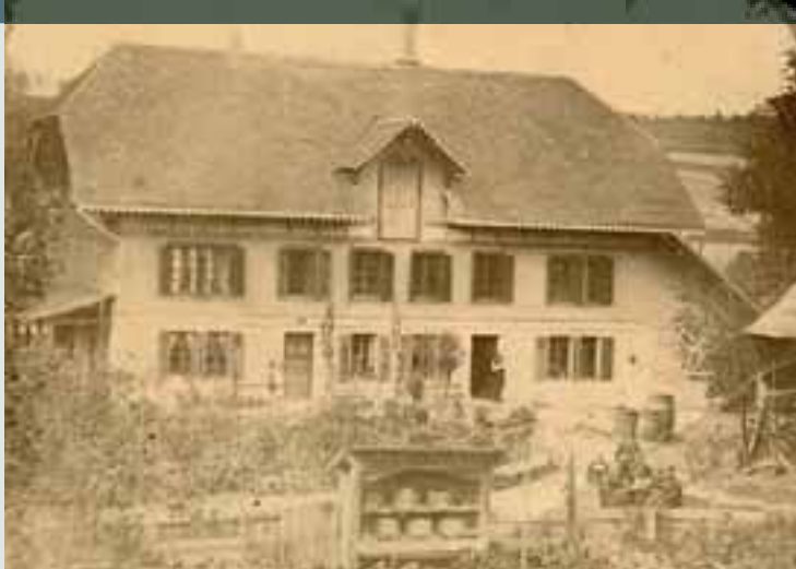
Das 1863 errichtete Wohn- und Gerbereigebäude im solothurnischen Bibern mit der Familie von Niklaus und Maria Hauert-Richener, um 1878.
