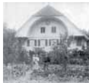
Wohn- und Gerbegebäude aus den 1850er-Jahren in Grossaffoltern.
