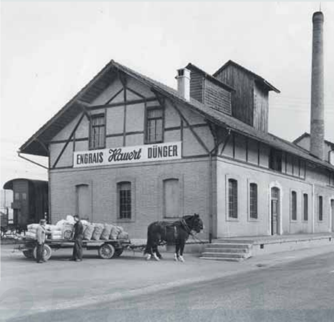
Die Düngerfabrik, um 1960.
